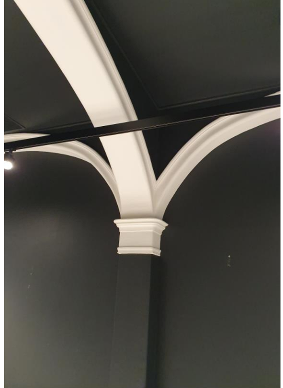
Bilde 18: 4.etg Takkonstruksjon Buede hvelvinger
