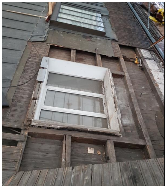
Bilde nr 20: Takkonstruksjon Takkonstruksjon med overlysvinduer fra 1970
