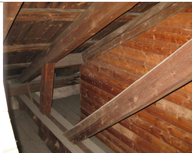
Bilde 17: Takkonstruksjon med buede hvelvinger som skjuler sperrebind.
