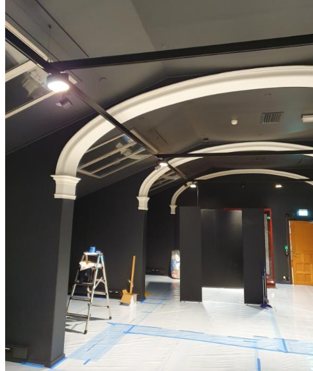
Bilde 17: Takkonstruksjon med buede hvelvinger som skjuler sperrebind.
