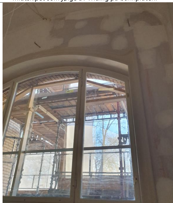
Bilde nr 23: Rom 115 Midskip Skade på overdekning og søyle mellom vinduer grunnet setninger. Bygget «Knekker» over midtskipet som følge av vridning på bunnplaten.
