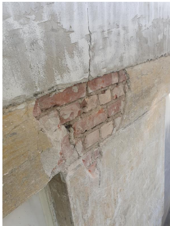
Bilde nr 23: Rom 115 Midskip Skade på overdekning og søyle mellom vinduer grunnet setninger. Bygget «Knekker» over midtskipet som følge av vridning på bunnplaten.
