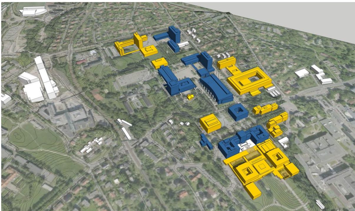
Figur 6: Rundt 70 % av fasadene på UiOs bygninger og en del interiører er fredet eller vernet. Figuren viser Campus Blindern, der blå bygninger er fredet og gule vernet.
