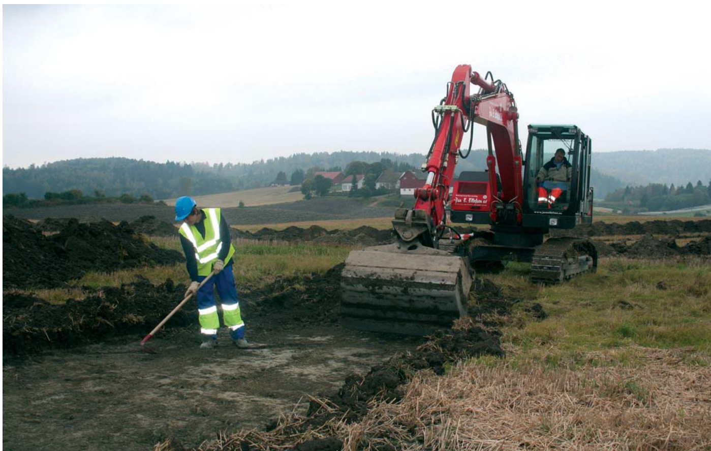
Figur 32: Sjaktning ved Rørkoll
