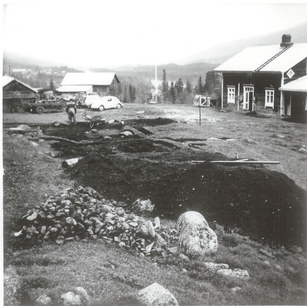
29.5.1971. Tuften dekkes til. Gravemasser i forgrunnen.
