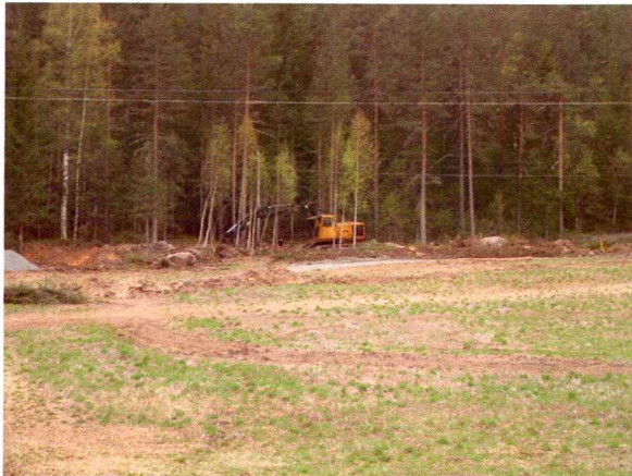
Bilde 1. Viser påbegynt anleggsarbeid innefor det bakkeplanerte området.
