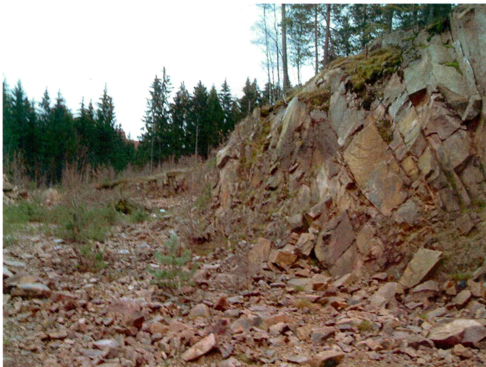
Deler av berget området er sprengt (mot SØ)
