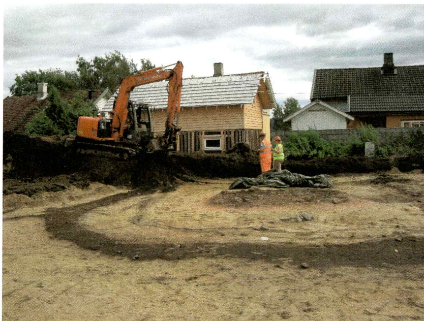
Produksjonsanlegg S 115 med to "ovner", omgitt av grøfter.
