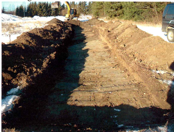
Foto 15: Sjakt 8 mot nordvest
