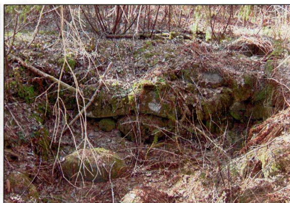
Del av indre kjellermur.
