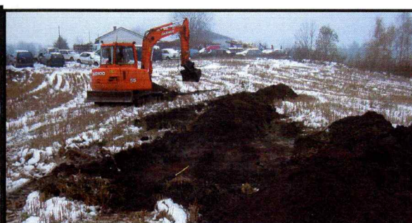
Sjaktene sett fra nord
