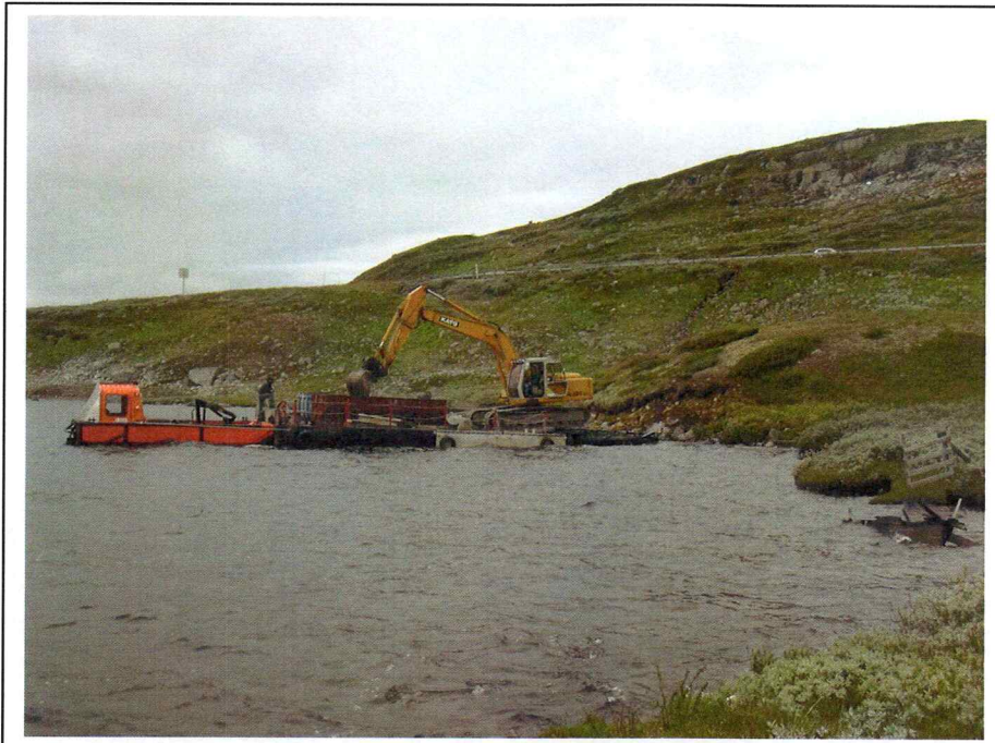
Erosjonssikring ved Halnelegret, legret ligger på høyden mellom vannet og veien.
