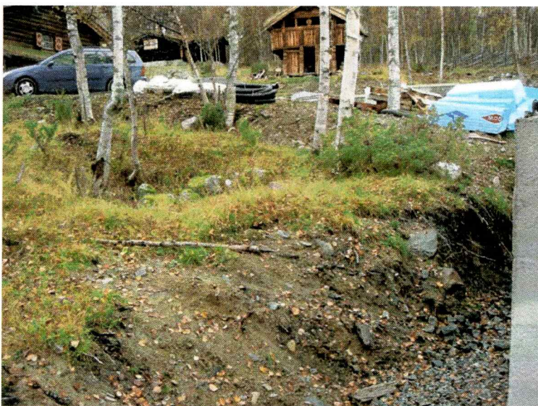
Nybygget til høyre har blitt gravd ned i undergrunnen og skadet vollen til R50. Kull kan ses i kanten. Foto: Erling Midtgard
