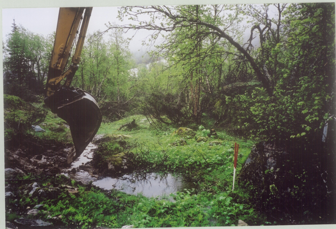
Foto 15 Grope mot SØ Graving av "dreneringsgrøft"
