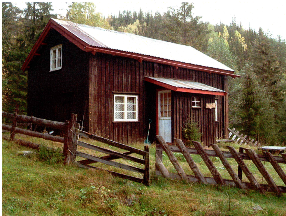
Våningshuset på Kleppebråten (mot NNØ)
