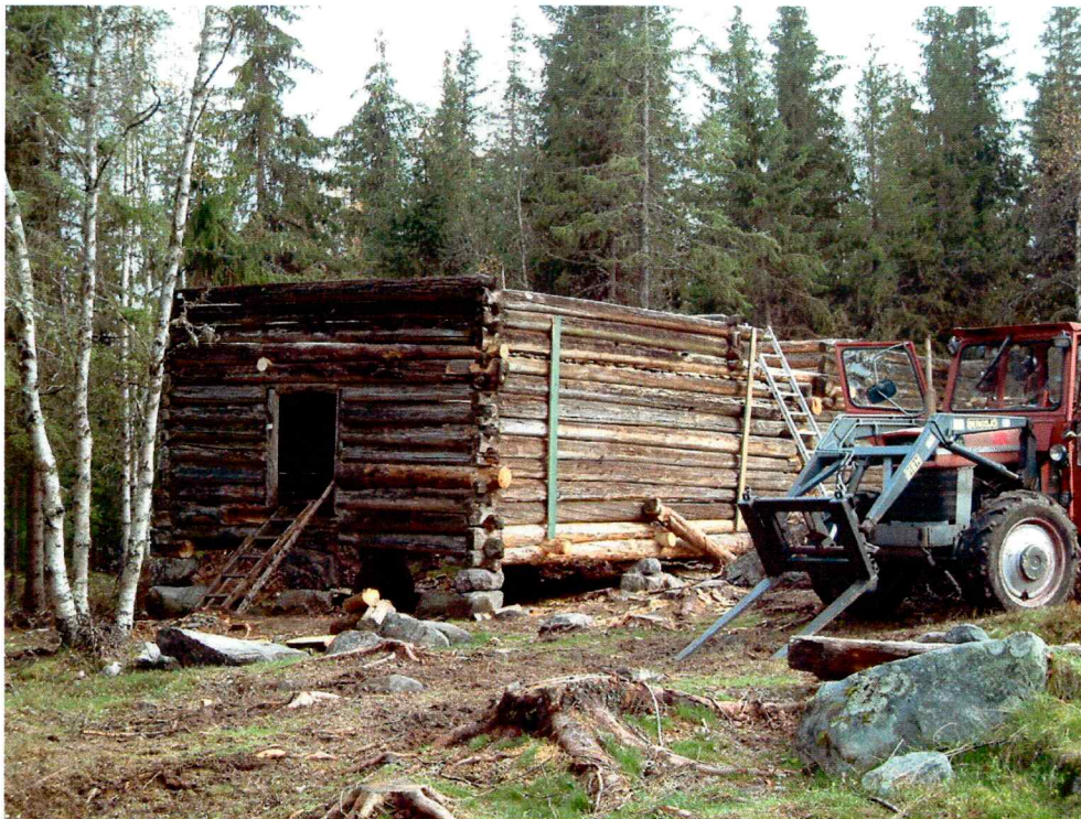
Restaurering av bygningen på tuft 2 (mot SØ)
