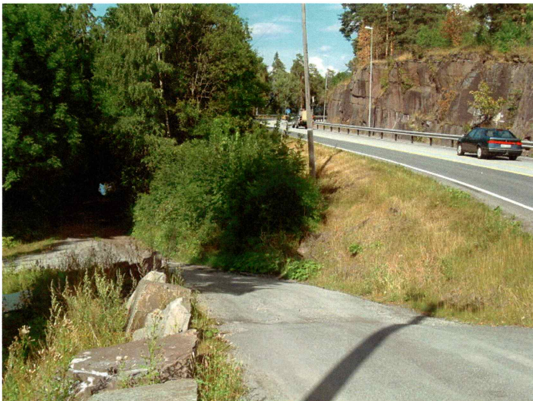
Gammel avkjøring til boliger nedenfor veien (mot NØ)
