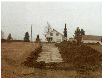
Bilde 4. Oversikt over sjakter
