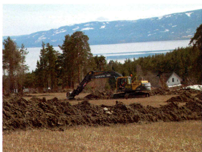
Bilde 7. Oversikt over sjakter.
