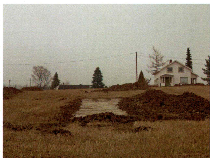
Bilde 3. Oversikt over sjakter.
