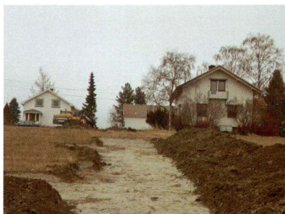
Bilde 5. Oversikt over sjakter.
