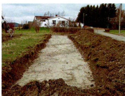
Bilde 2. Sjakt fra Fossumveien.
