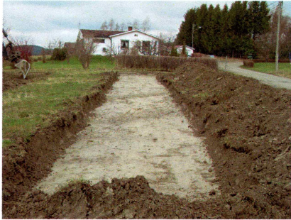
Bilde 11 – Sjakt Fossumveien
