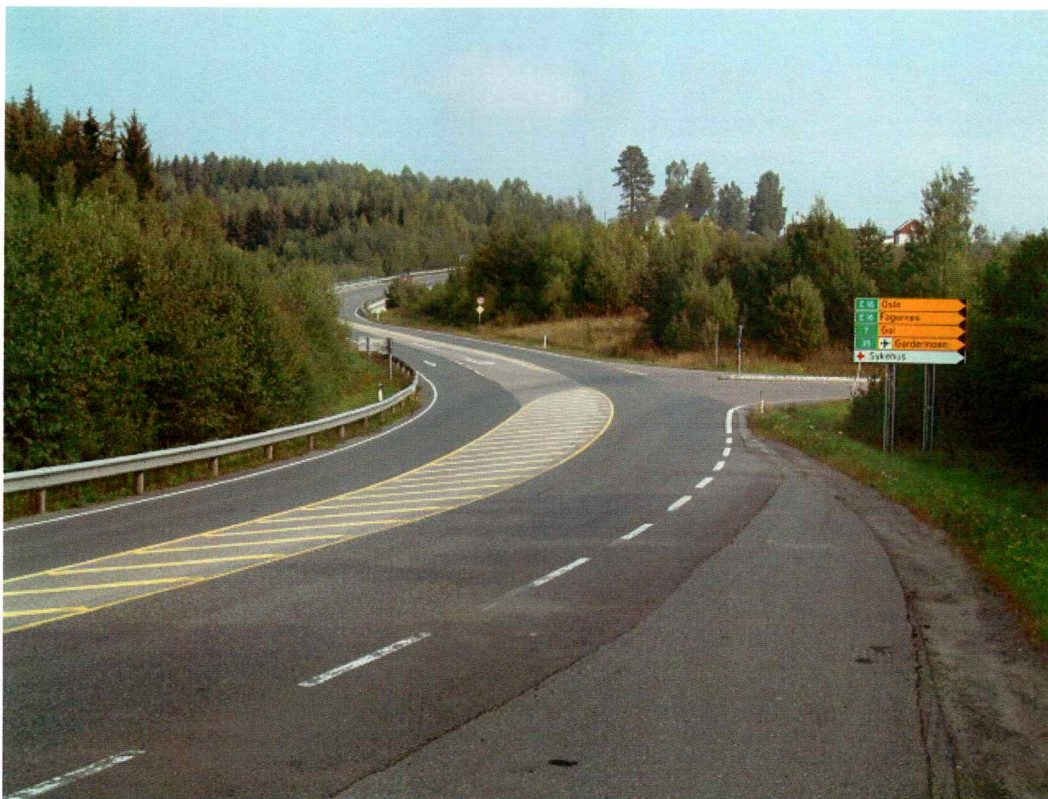
Dagens avkjøring fra Rv 35 (mot NNØ)
