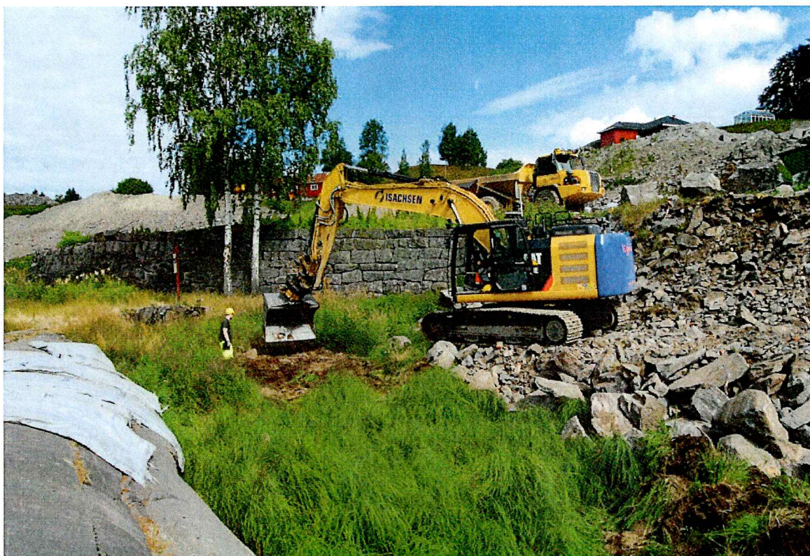
Figur 6: Fjerning av vegetasjonen, bildet er tatt mot N/NV
