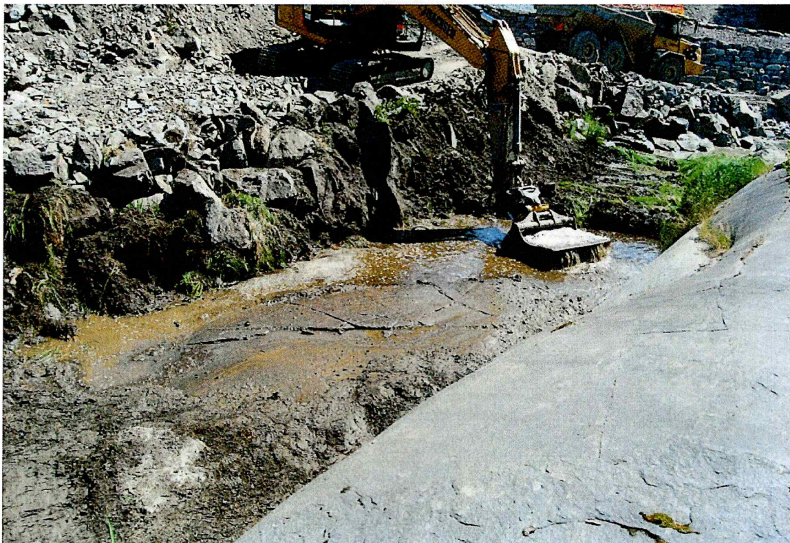
Figur 11: Drenering av vannet med gravemaskinen, bildet er tatt mot Ø/SØ
