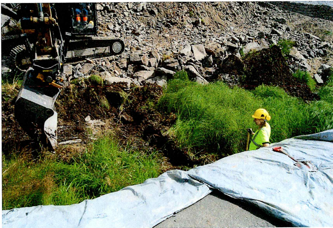
Figur 10: Avdekking av torv, kontrollsjakt kan sees. Bildet er tatt mot Ø/NØ
