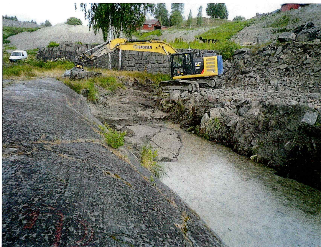
Figur 16: Oversiktsbilde etter at prosjektet er avsluttet, bildet er tatt mot NV
