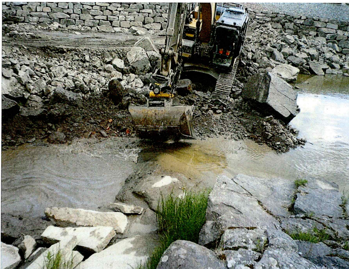
Figur 13: Fjerning av fylling for å åpne opp for vannet, bildet er tatt mot SØ
