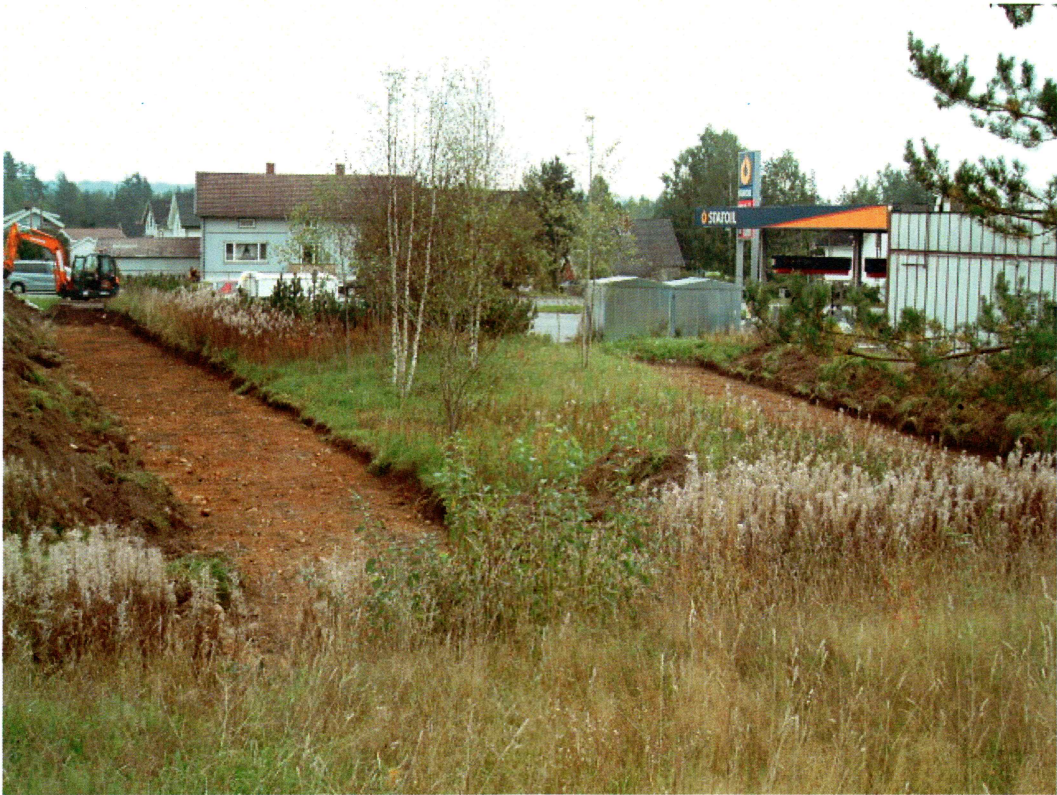
Oversikt over sjaktene (mot SV)
