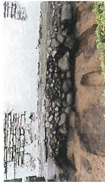
Jelling Kirke. Udgravningen øst for koret med en bemærkelsesværdig kraftig forstærkning af fundamentets midterste del. – Fot. Hans Mikkelsen.
