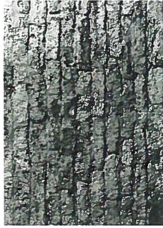
To frådstensmure. T.v. regelmæssigt murværk indvendigt i Ørriidslev Kirkes kor. T.h. det meget uregelmæssige murværk i Jelling Kirkes korgavl. – Fot: Nationalmuseet.
