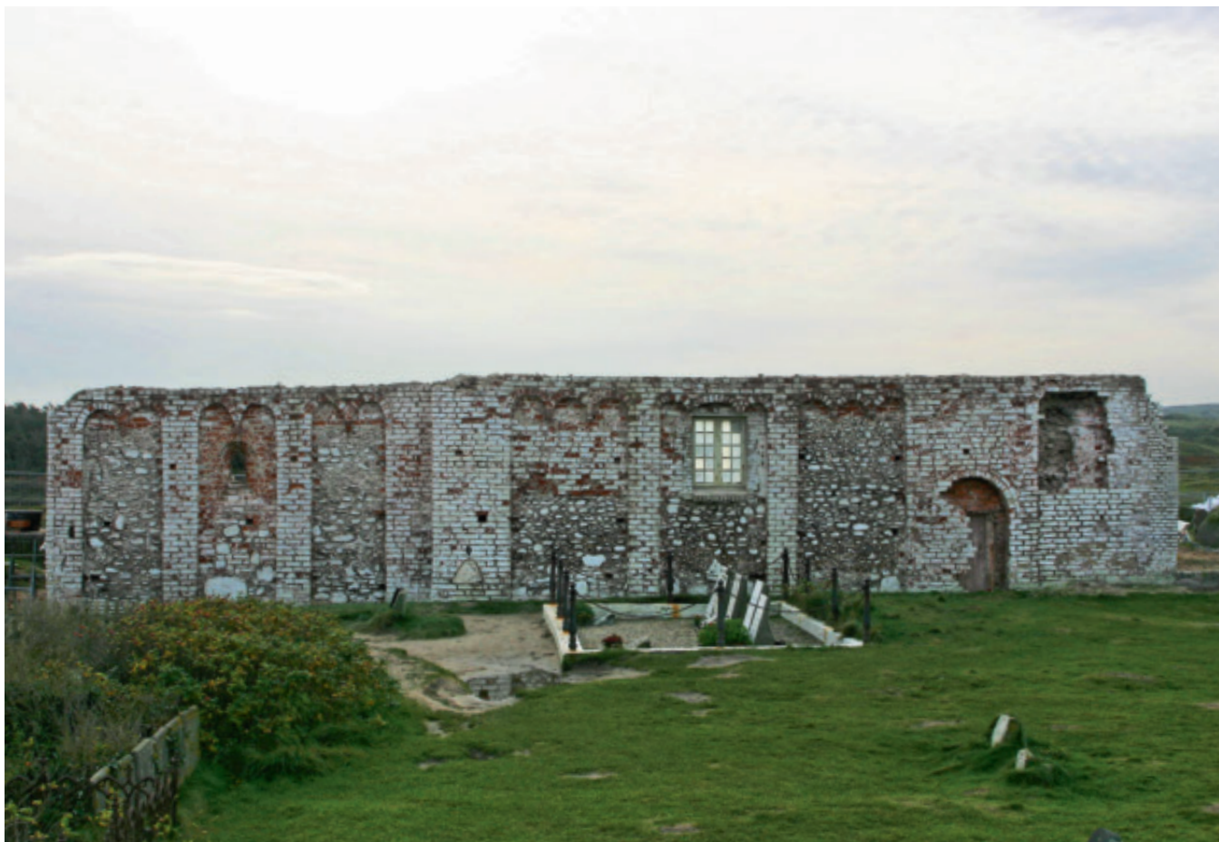
Fig. 8. Kirkens afrensede nordfacade (sammenlign fig. 3). Facadekalken kunne ikke fjernes, men fugerne mellem de enkelte sten i den velbevarede mur er udhugget. Foto: Thomas Bertelsen 2008.
