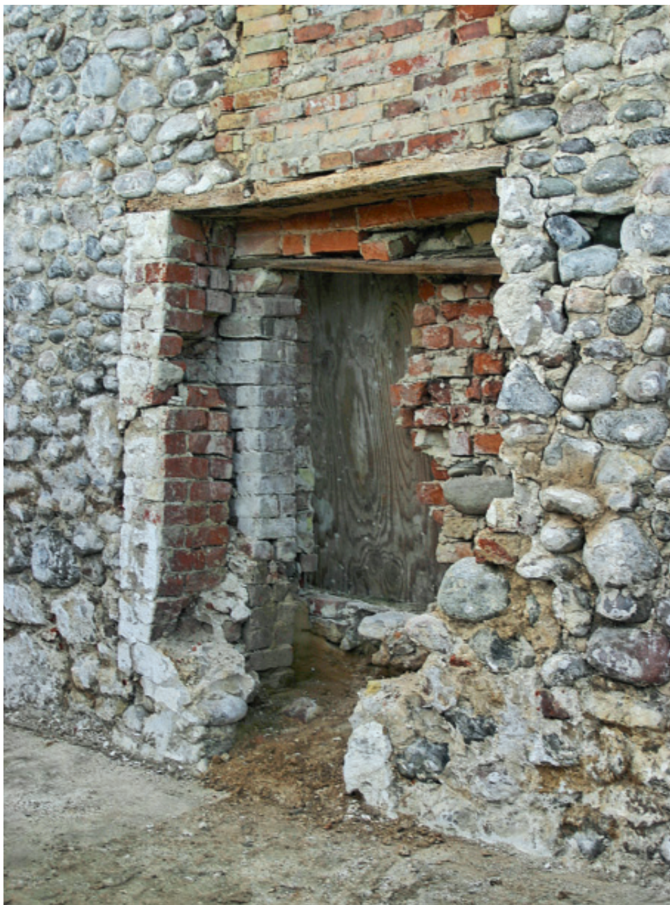
Fig. 6. Skibets genåbnede norddør set inde fra kirkerummet. Både åbningen og den indvendige niche er afdækket af en egeplanke, hvoraf den sværeste i forgrunden stammer fra et egetræ fældet omkring 1202. Den udmurede niche over døren blev etableret i 1800-tallet som indramning for en mindetavle, der siden er overført til Lønstrup Kirke. Foto: Thomas Bertelsen 2008.
