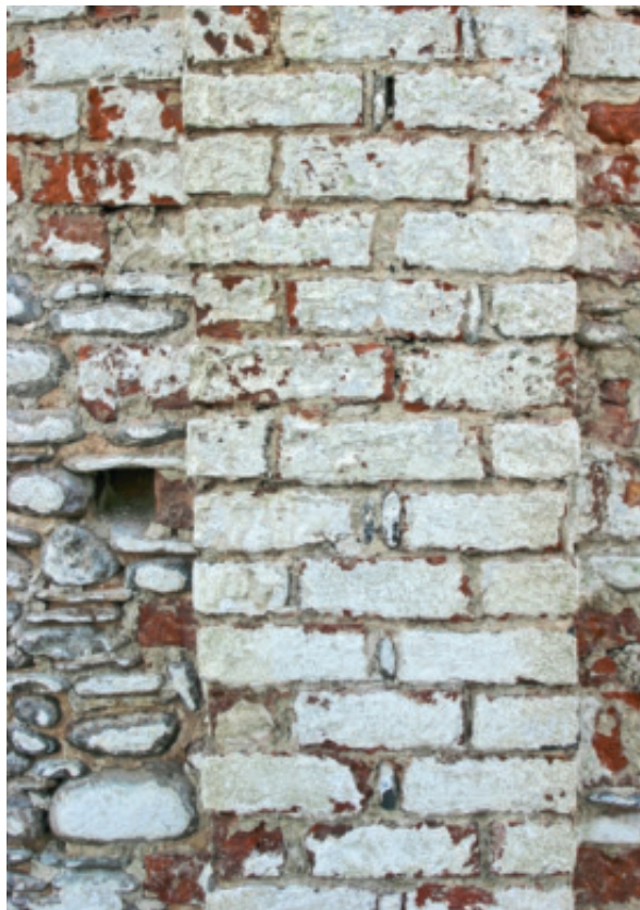
Fig. 12. Udsnit af skibets nordfacade. I både kor og skib er mange af de lodrette fuger mellem teglstenene udfyldt med en flad granitsten. Foto: Thomas Bertelsen 2008.
