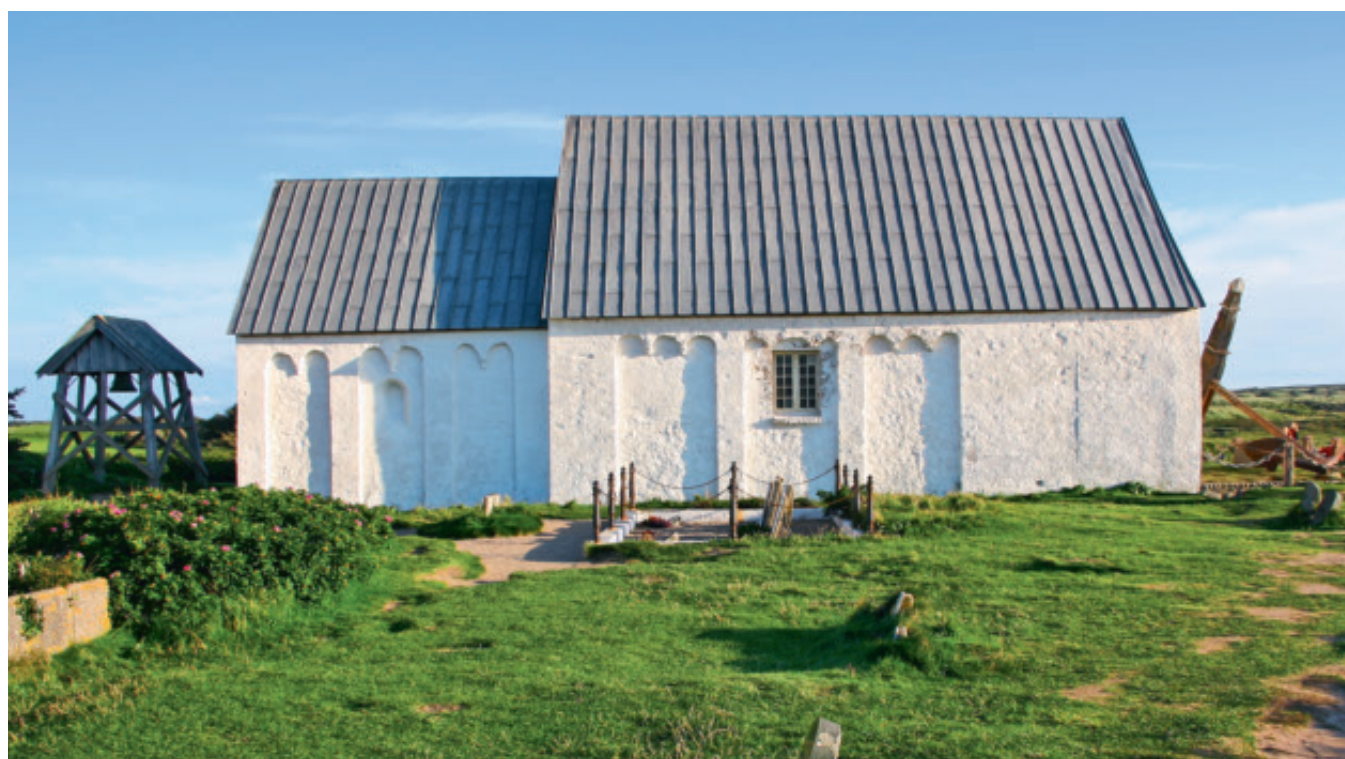
Fig. 3. Kirkens velbevarede nordfacade set fra nord umiddelbart før nedtagningen. Både korets og skibets mur er opdelt af flade liseners, så de danner blændingsfelter, som foroven er afsluttet med en buefrise. I strejflys ses den østre side af endnu en tilmuret blænding vestligst på facaden. I en bred lisen ved dens østside er den nu tilmurede norddør placeret. Foto: Thomas Bertelsen 2008.
