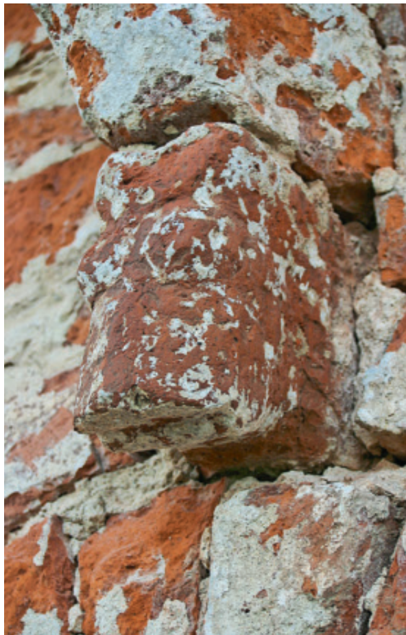
Fig. 9. Hovedformet konsolsten fra buefrisen over korets nordvindue. Også facadens øvrige oprindelige teglstenskonsoller er udformet som menneske- eller dyrehoveder. Foto: Thomas Bertelsen 2008.
