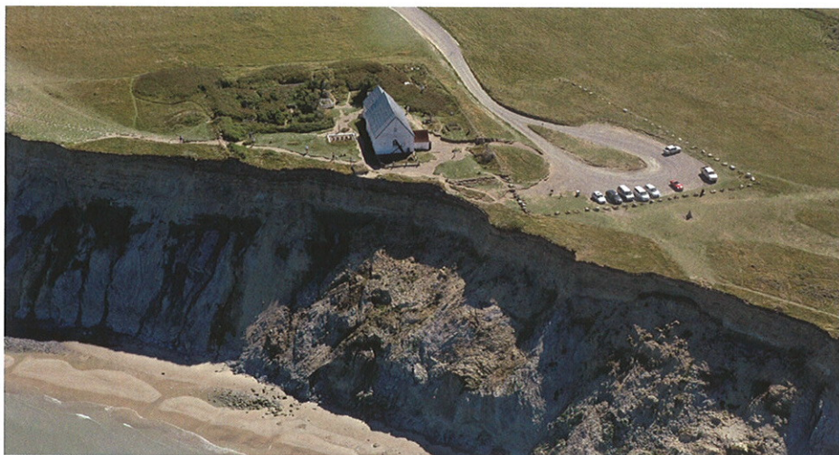
Fig. 1. Mårup Kirke yderst på klinten, kort tid før nedtagningen. På luftbilledet ses, at kirkegårdens nordvestre hjørne allerede er styrtet i havet.
