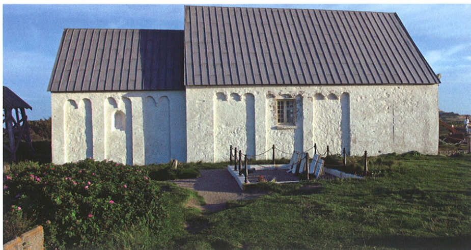
Fig. 2. Kirkens velbevarede nordfacade med høje blændinger adskilt af lisenner. Lignende dekorationer genfindes på flere andre romanske teglstenskirker i Vendsyssel.
